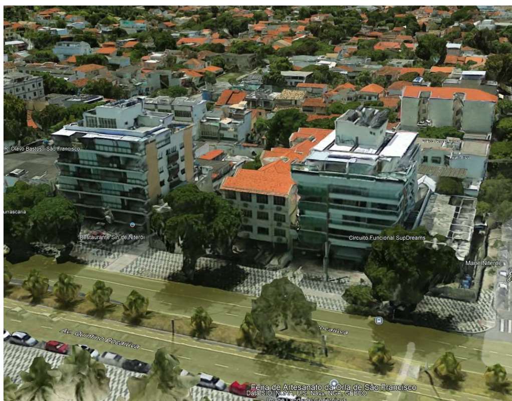
Figura 23: Grandes construções já em uso na Avenida Quintino Bocaiuva – Fonte: Autor
